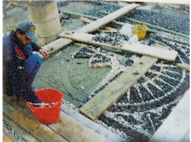
fig. 3 - 4 - due fasi della posa del nuovo acciottolato, seguendo il disegno antico
