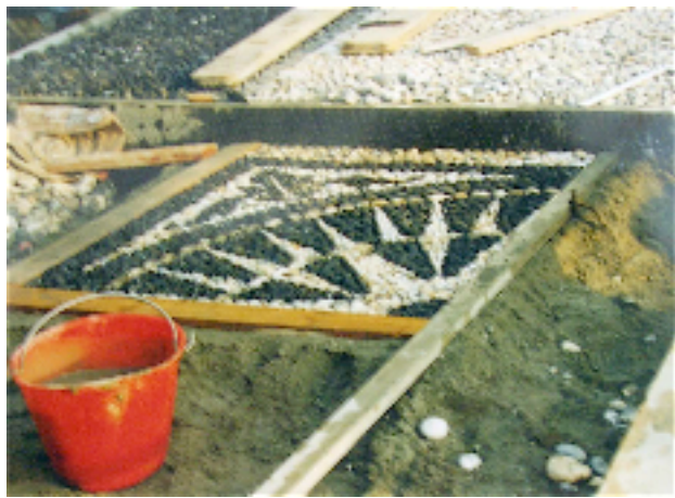
fig. 3 - 4 - due fasi della posa del nuovo acciottolato, seguendo il disegno antico
